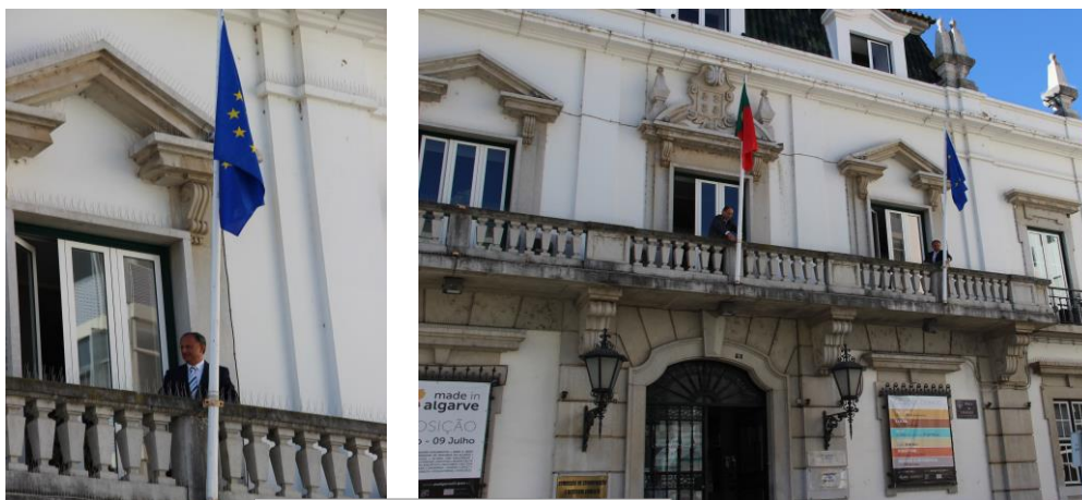
Edifício da Autoridade de Gestão
